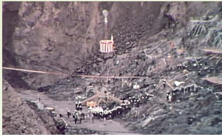
S47.12 基礎岩盤に最初のコンクリート打設
