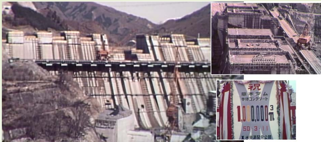
S50.3 100万m 3 打設完了(全体132万m 3 )
