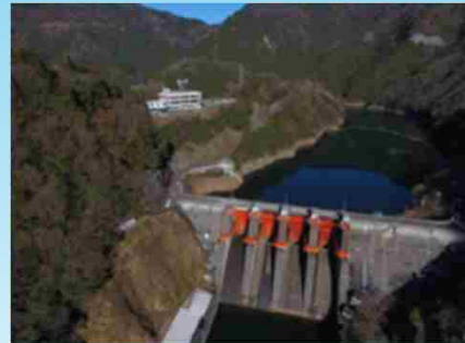
柳瀬ダムの下流「新宮ダム」
