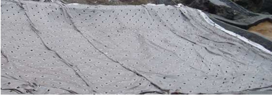
布製型枠材質：合成繊維
