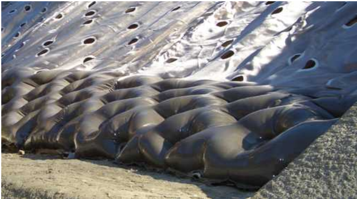
布製型枠充填材：1:2モルタル
