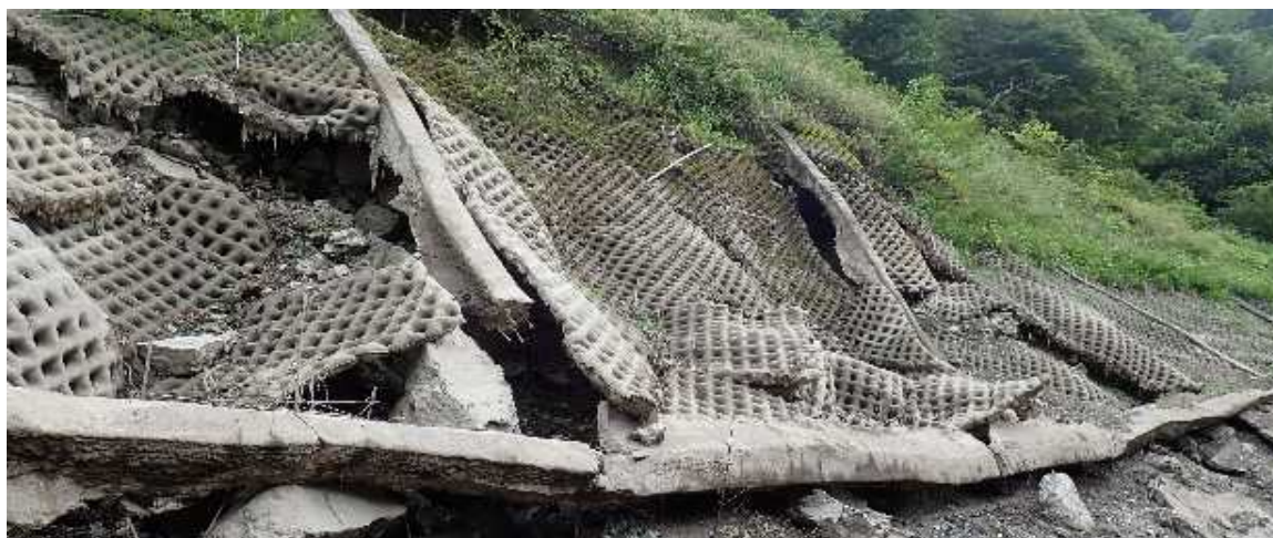
布製型枠拡大写真
