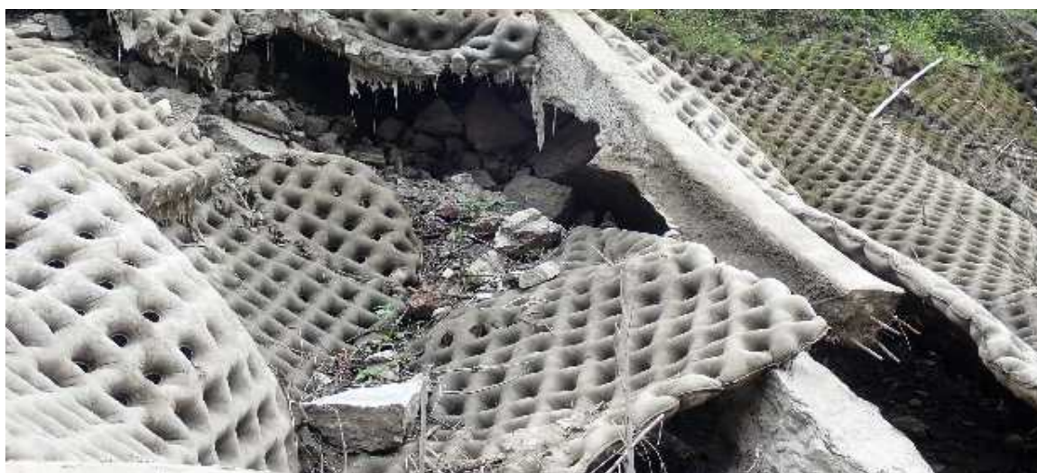
布製型枠拡大写真
