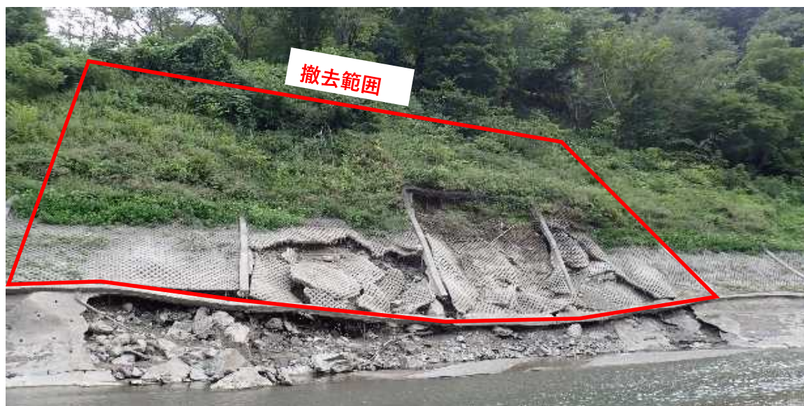
布製型枠[合成繊維+1:2モルタル]：処分量 約100m 3 (約210t)
