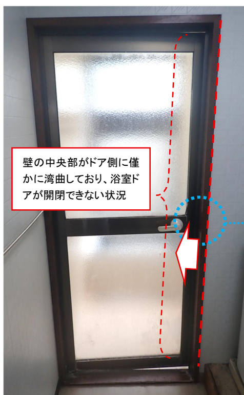
○浴室ドア全景
