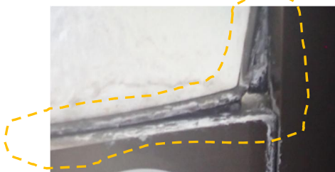
○窓部分ビート現況
