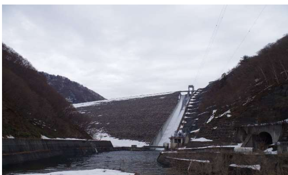
奈良俣ダム下流より堤体を撮影
