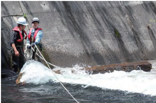
流れ着いた流木を撤去。(湯ノ小屋取水堰ラバーゲート)
