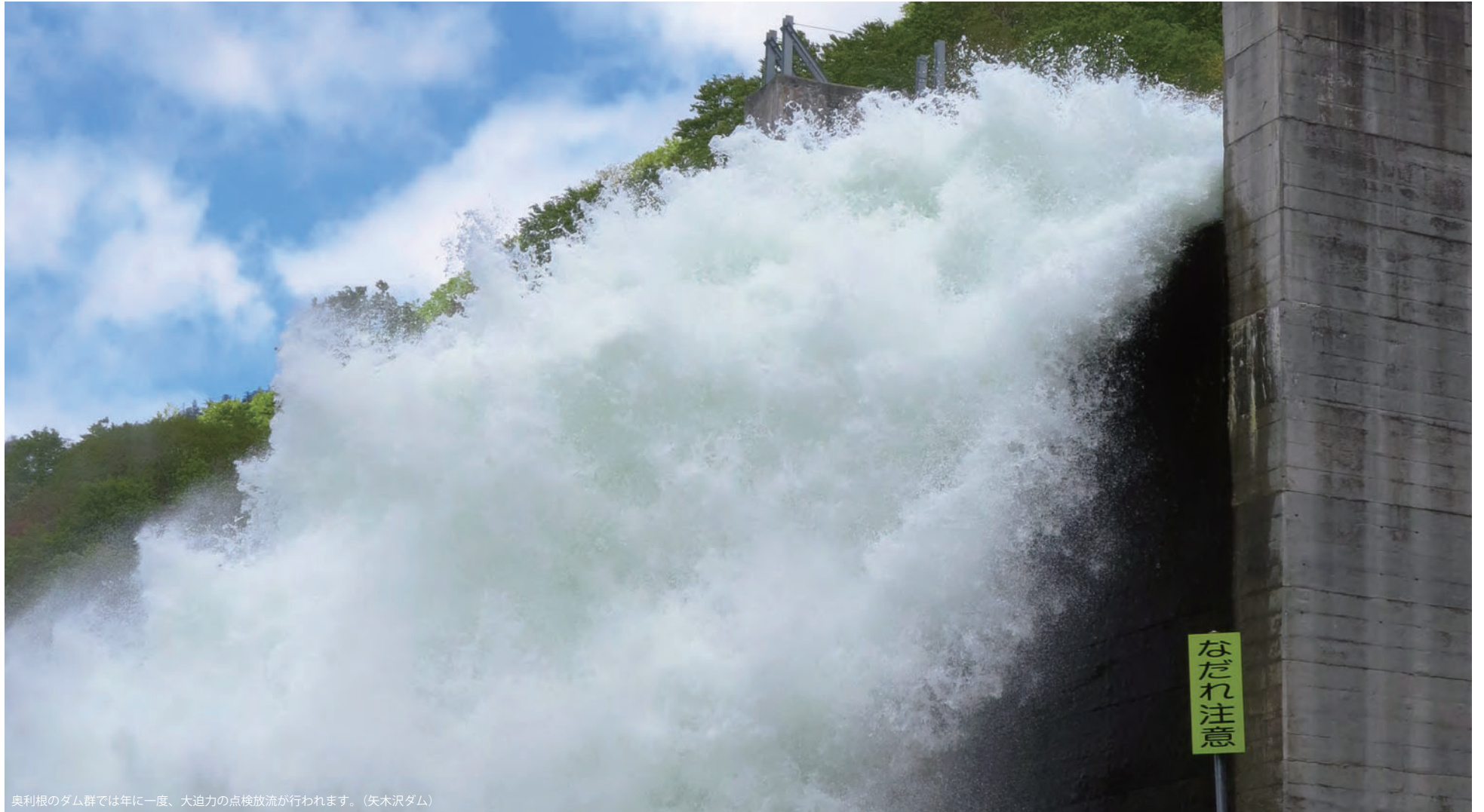
奥利根のダム群では年に一度、大迫力の点検放流が行われます。(矢木沢ダム)
