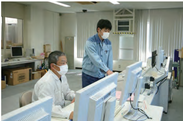
奈良俣ダム操作室。ダムを適切に操作するため、気象や水位など毎日観測しています。
