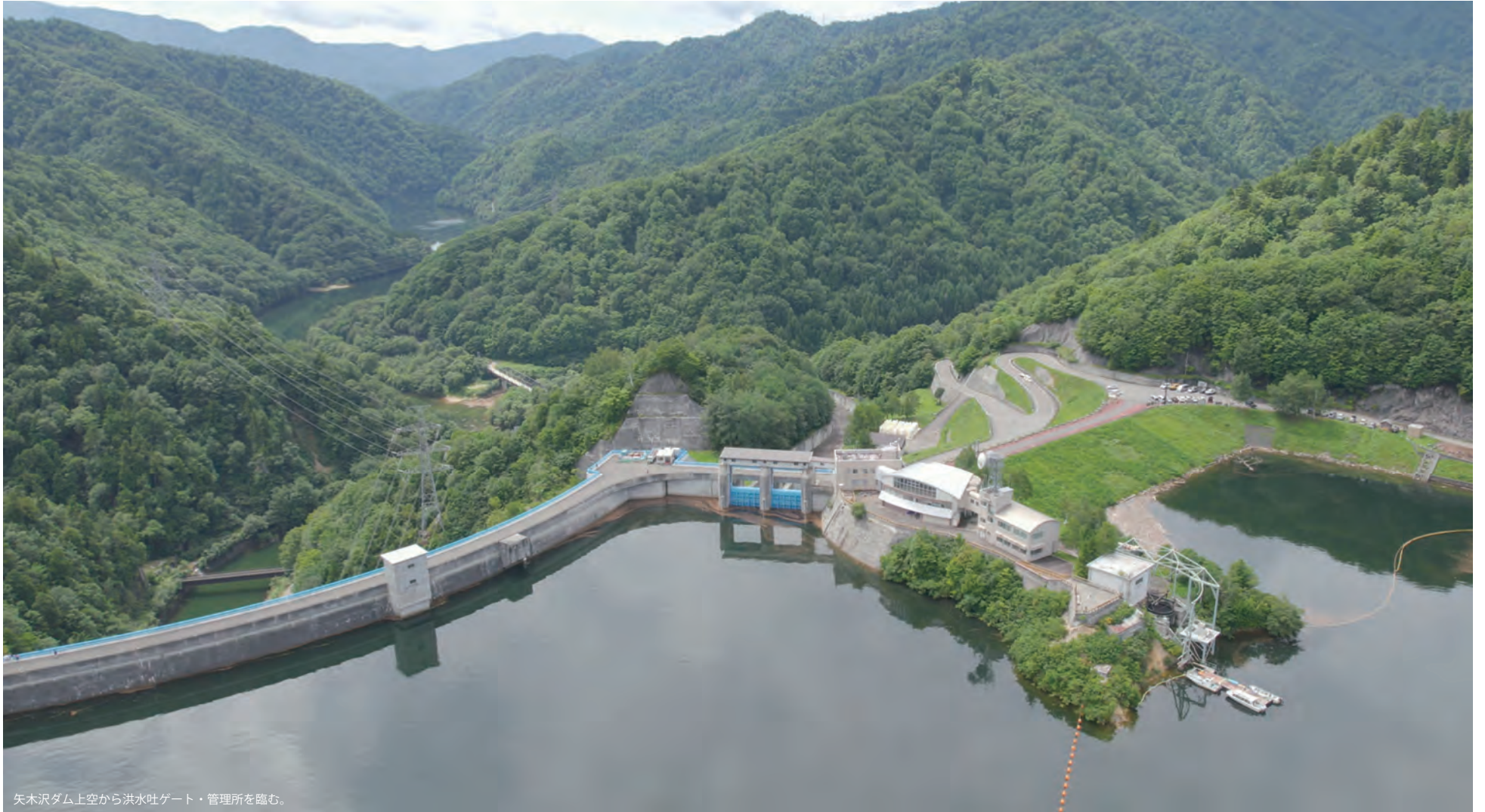
矢木沢ダム上空から洪水吐ゲート・管理所を臨む。
