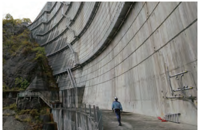
アーチ型の堤体も奥利根の自然と共に歳月を重ねて来ました。(矢木沢ダム)
