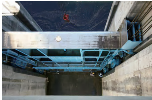
工事が正常に行われるように、ゲートを細部まで確認します。
