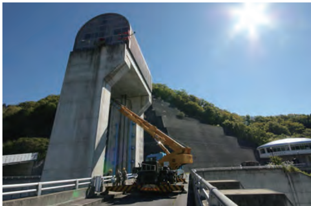
奈良俣ダム の再生事業による、洪水吐ゲートを取り替える工事。
