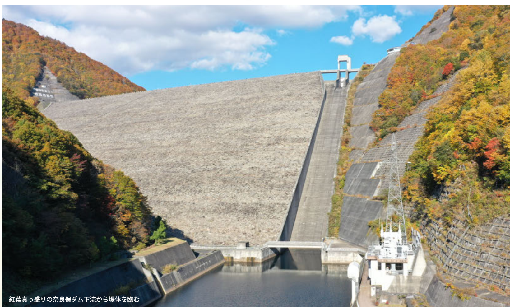
奥利根の山々の彩りと矢木沢ダム管理所
