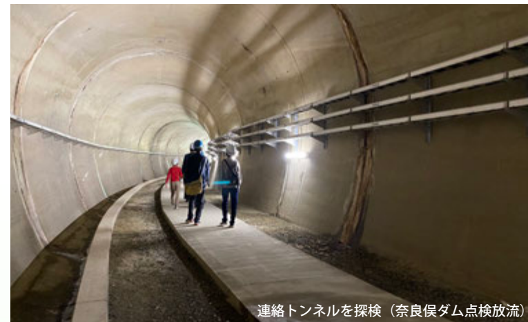
連絡トンネルを探索（奈良俣ダム点検放流）
