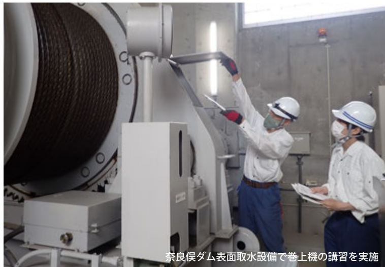
奈良俣ダム表面取水設備で巻上機の講習を実施
