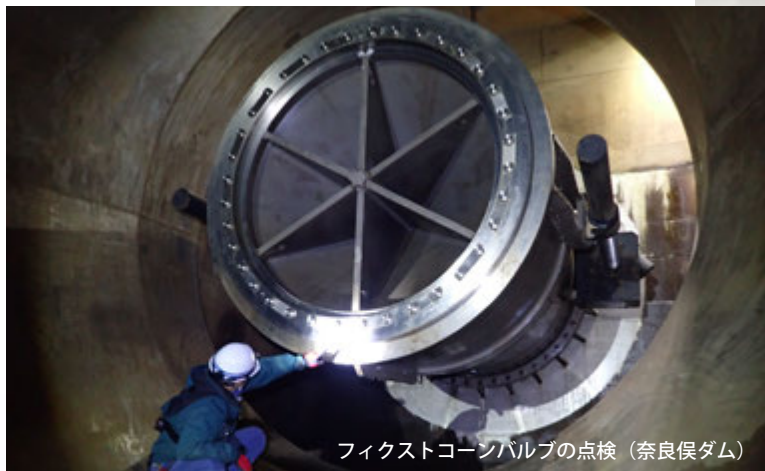
フィクストコークバルブの点検（奈良俣ダム）
