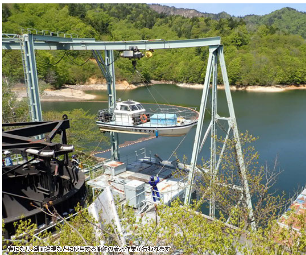
春になり、湖面巡視などに使用する船舶の着水作業が行われます
