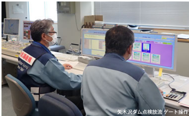
矢木沢ダム点検放流 ゲート操作
