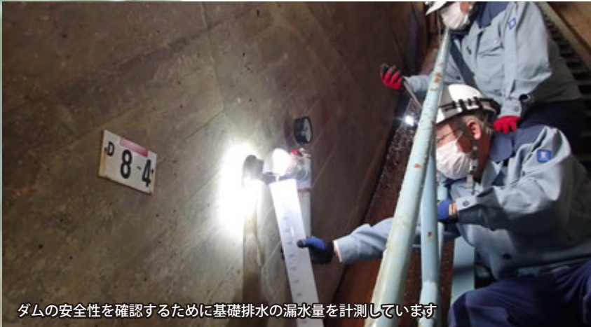
ダムの安全性を確認するために基礎排水の漏水量を計測しています
