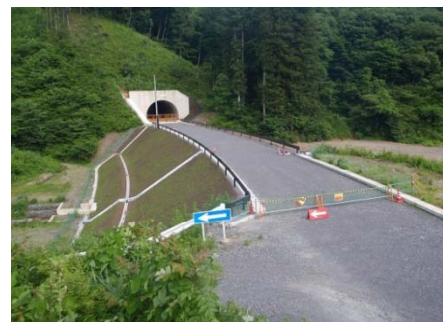
⑥ 付替県道1号トンネル工事 (H24.8竣工)
