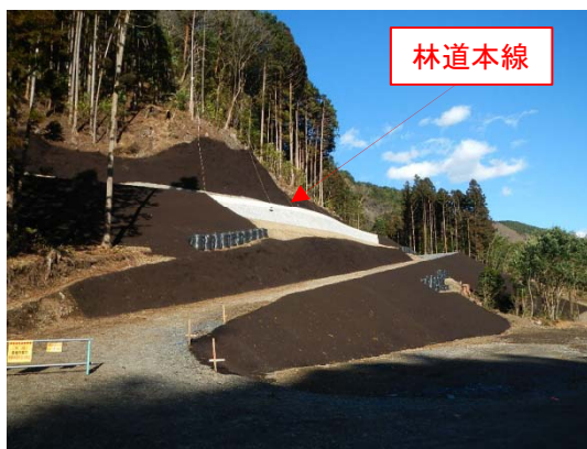
完成 (平成30年3月)
