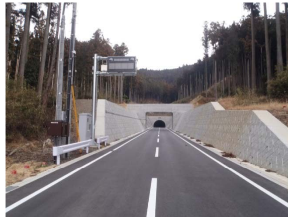
完成 (引田側) (平成29年11月)
