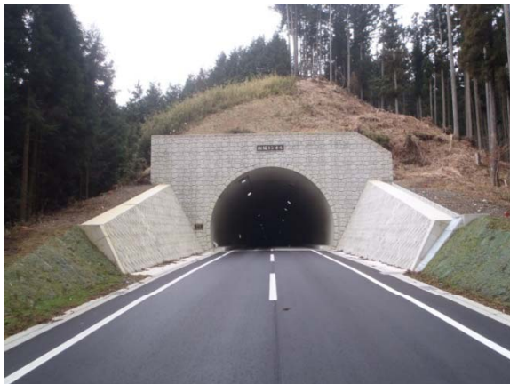
完成 (板荷側) (平成29年11月)
