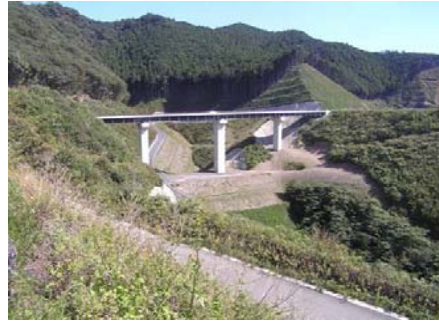
③ 付替県道6号橋工事 (H23.10竣工)
