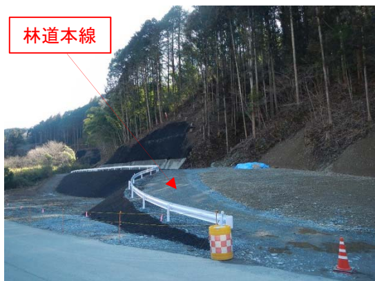
完成 (平成30年3月)
