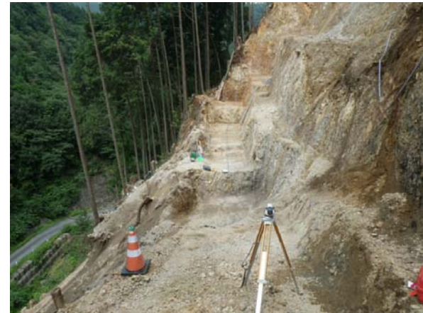
擁壁基礎部床付状況
