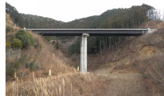
完成 (平成29年12月)
