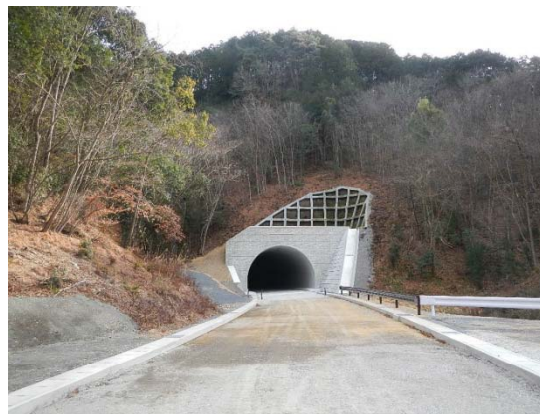
完成 (平成29年12月)
