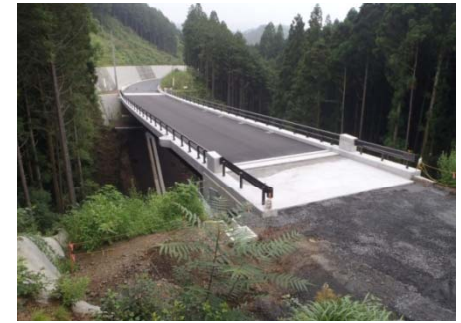
① 付替県道7号橋工事 (H25.8竣工)
