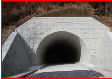
⑤ 付替県道2号トンネル工事 (H29.12竣工)
