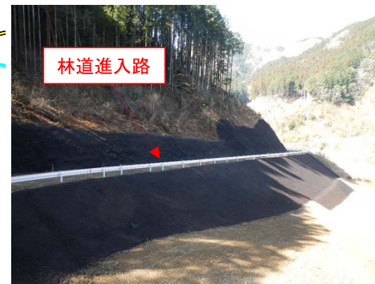
完成 (平成30年3月)
