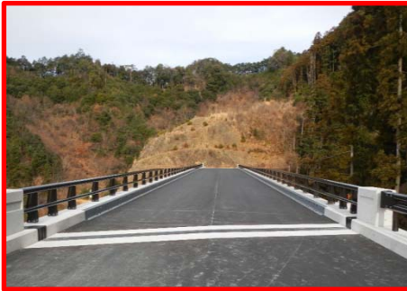
④ 付替県道5号橋工事 (H29.12竣工)
