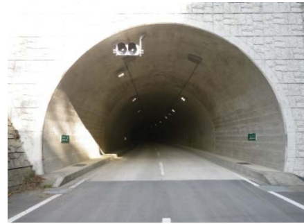
② 付替県道4号トンネル工事 (H28.3竣工)
