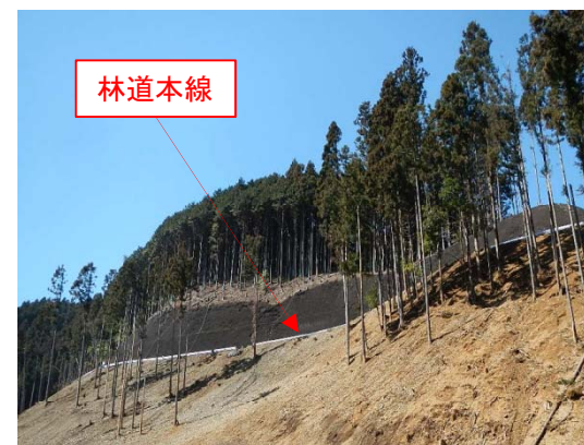
完成 (平成30年3月)
