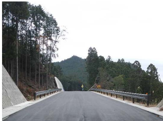
完成 (平成29年12月)
