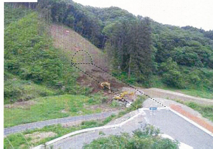
⑩ 付替県道1号トンネル H22.06
