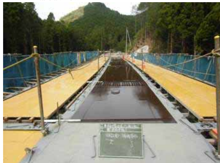
H25.04 桁架設工状況
