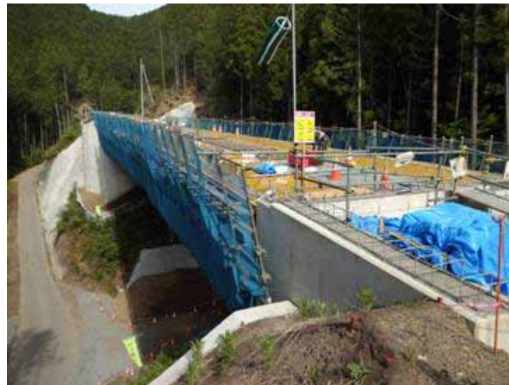
H25.04 桁架設工状況
