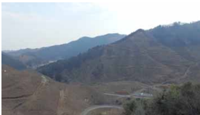
①ダムサイト伐採状況 (平成31年2月)
