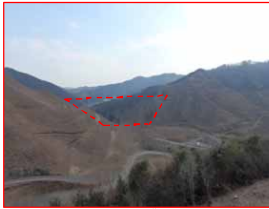
② ダムサイト伐採工事（施工中）
