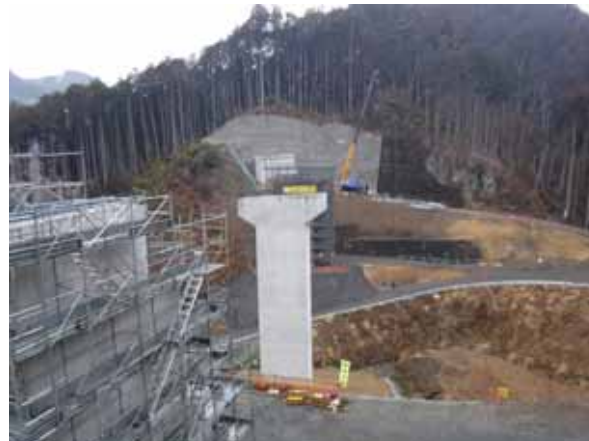
施工中 (平成31年2月)
