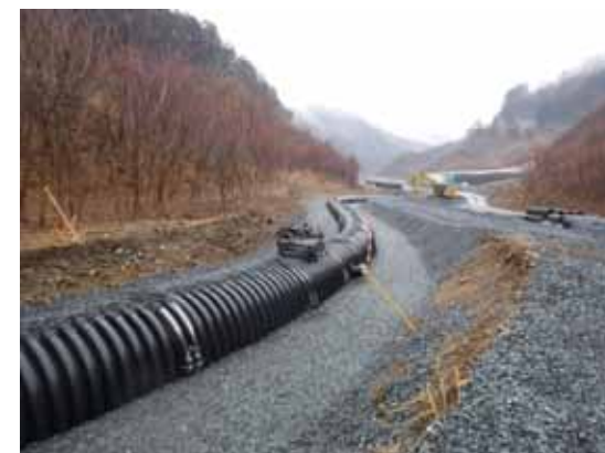
②建設発生土受入地整備 地下排水管設置状況 (平成31年2月)
