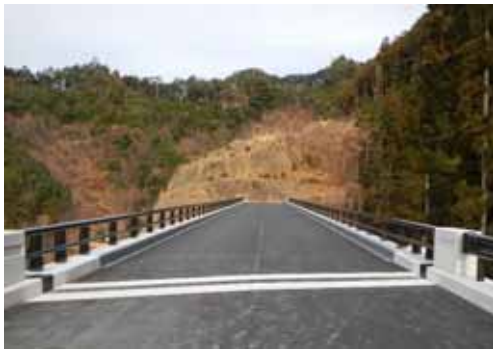
④ 付替県道5号橋工事（H29.12竣工）
