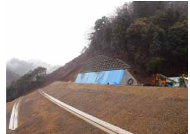
施工中 (平成31年2月)
