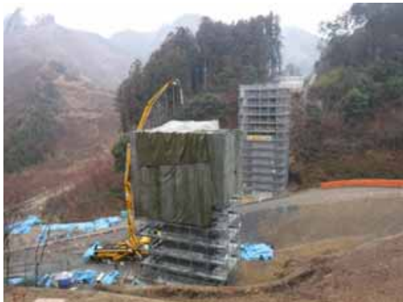
施工中 (平成31年2月)
