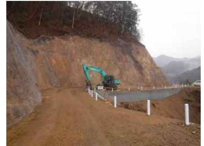
施工中 (平成31年2月)
