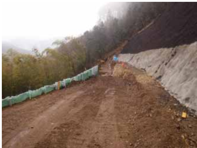
施工中 (平成31年2月)
