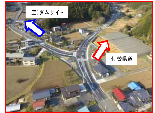
① 付替県道交差点工事（H31.2竣工）
