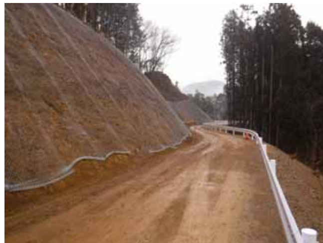
施工中 (平成31年2月)
