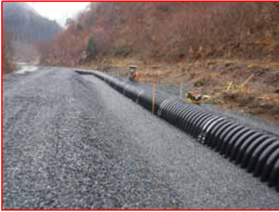
③ 建設発生土受入地整備工事（地下排水管施工中）
