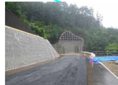
⑦付替県道5号トンネル工事 (R2.3.26~R3.2.18)
