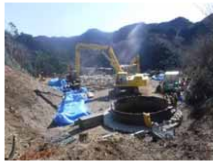
③付替県道9・10号橋下部工工事 (R1.11.13~R2.7.9)
