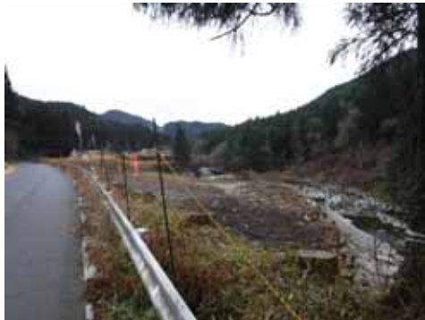
黒川導水路 着工前
