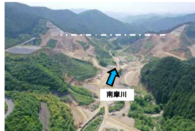
施工状況 全体(令和2年6月)
