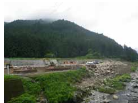
大芦川導水路 施工状況(令和2年6月)
