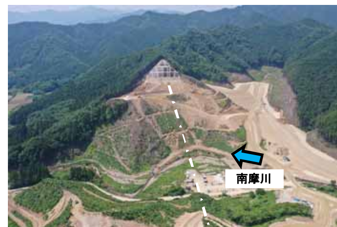
施工状況 右岸(令和2年6月)
