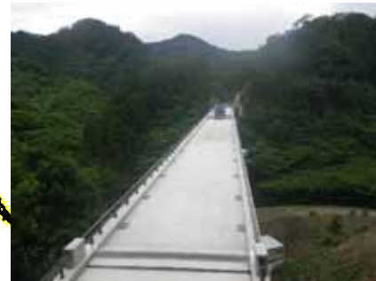
⑥付替県道1号橋上部工工事 (H31.2.26~R2.8.28)
