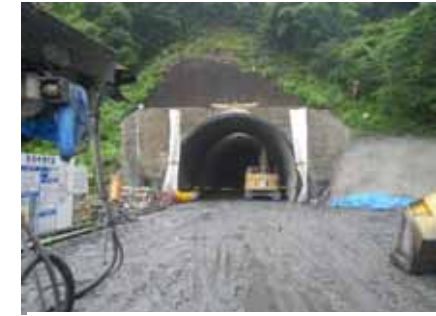
①付替県道3号トンネル工事 (R2.2.13~R3.2.6)
