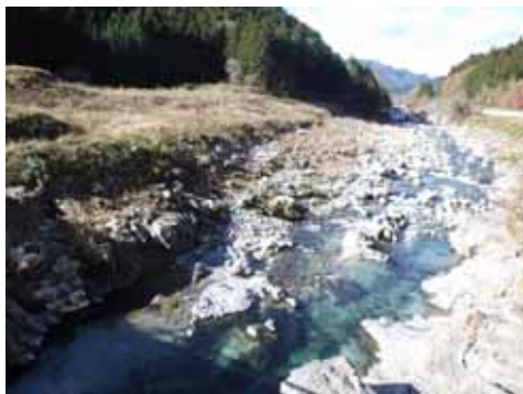
大芦川導水路 着工前
