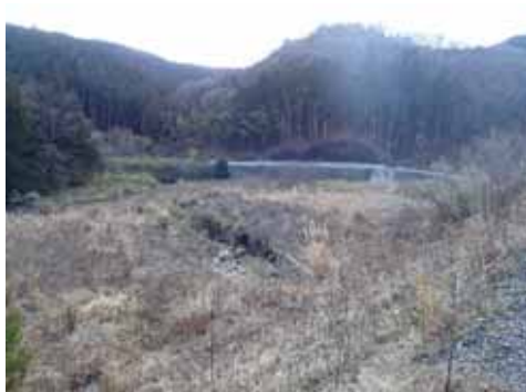
南摩注水工 着工前
