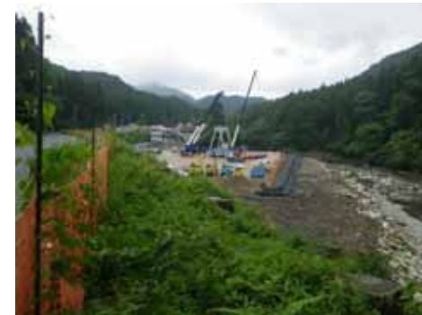
黒川導水路 施工状況(令和2年6月)
