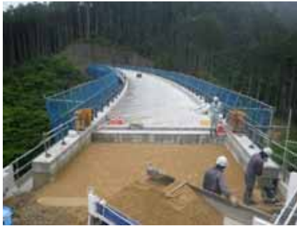
⑤付替県道2号橋上部工工事 (H31.2.15~R2.7.18)
