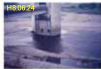
小山市水道取水口
