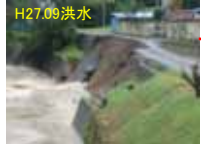
南摩川の出水による被害
