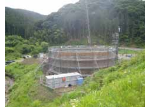
南摩注水工 施工状況(令和2年6月)
