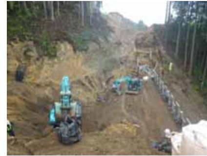
②付替県道粟沢4工区工事 (R1.9.25~R2.8.19)
