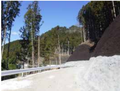
④付替林道西ノ入上流3工区工事 (R2.4.30 完成)
