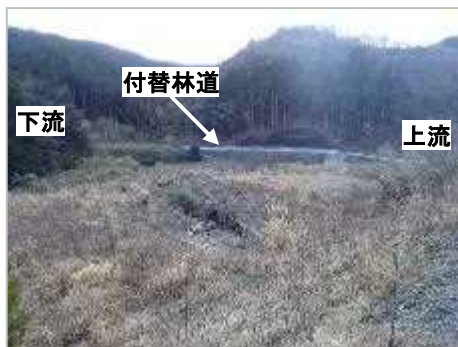
南摩注水工 着工前
