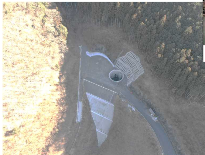
サージタンク工 施工状況(令和4年1月)
