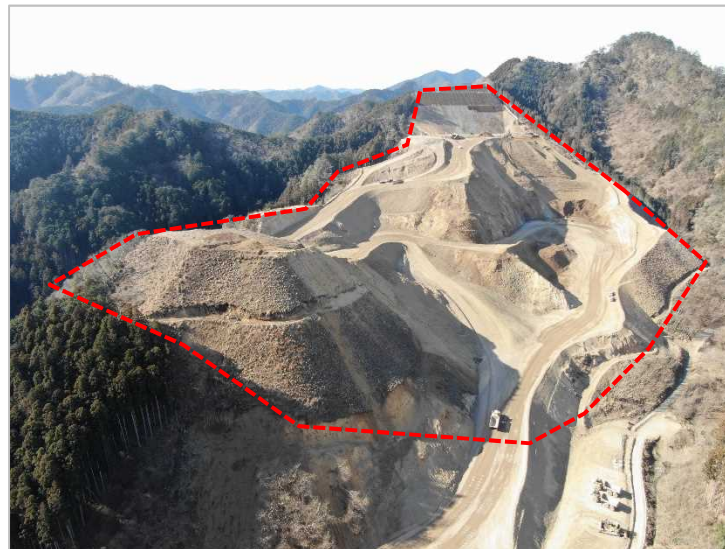
原石山掘削 施工状況(令和4年1月)
