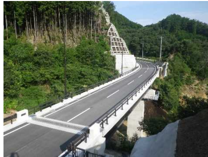
③付替県道9・10号橋上部工工事 (R2.2.13~R3.6.26)
