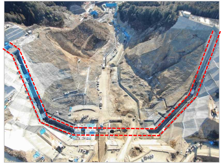
プリンスE 施工状況(令和4年1月)
