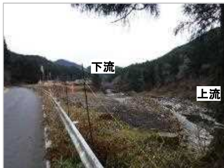
黒川取水放流工 着工前
