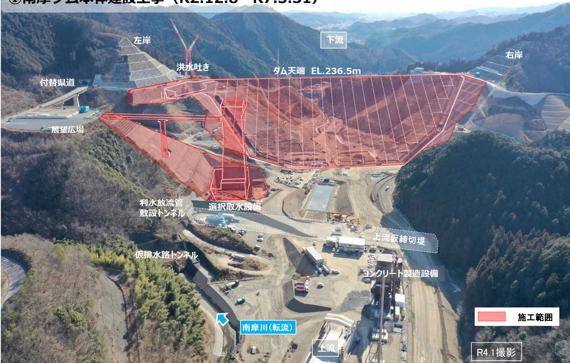
航空写真(堤体上流側から下流方向を撮影)
