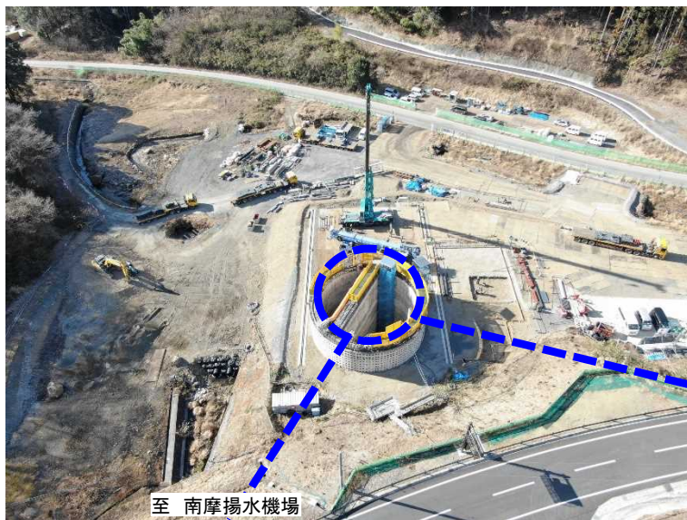
南摩注水工 施工状況(令和4年1月)
