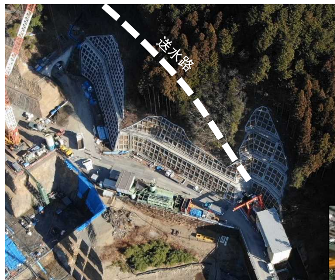
送水路施工ヤード整備工 施工状況(令和4年1月)
