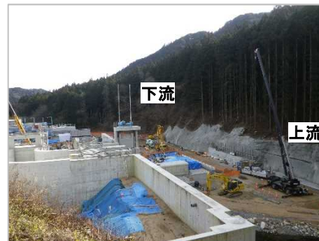
黒川取水放流工 施工状況(令和4年1月)
