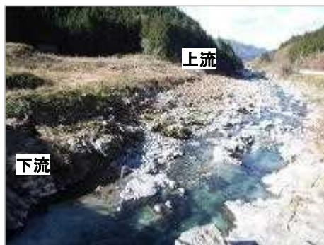
大芦川取水放流工 着工前
