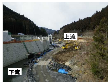
大芦川取水放流工 施工状況(令和4年1月)
