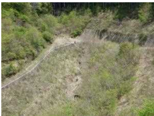
サージタンク工 着工前
