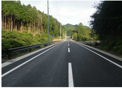
④付替県道粟沢6・8工区他工事 (R2.7.18~R3.8.20)
