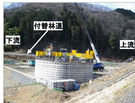
南摩注水工 施工状況(令和4年1月)
