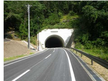
②付替県道5号トンネル工事 (R2.3.26~R3.6.24)
