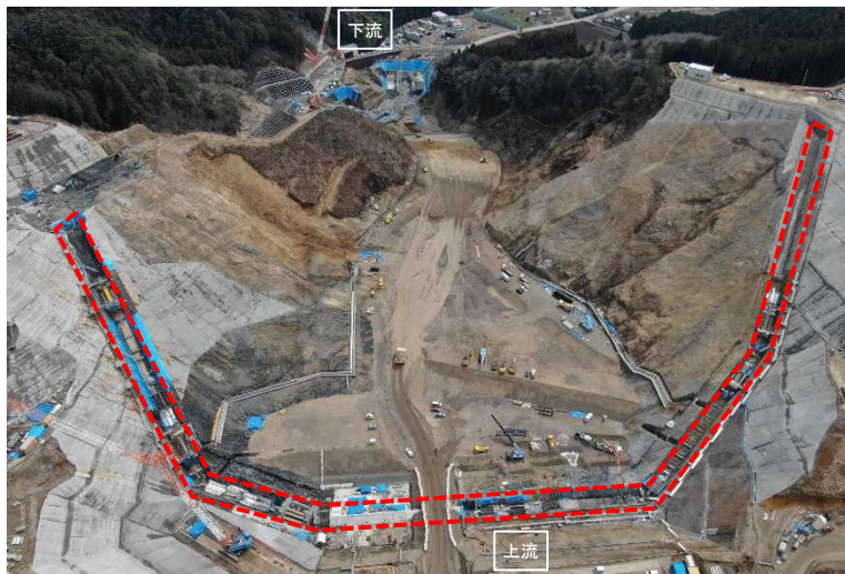
堤体工(盛立)・プリンス 施工状況(令和4年4月)
