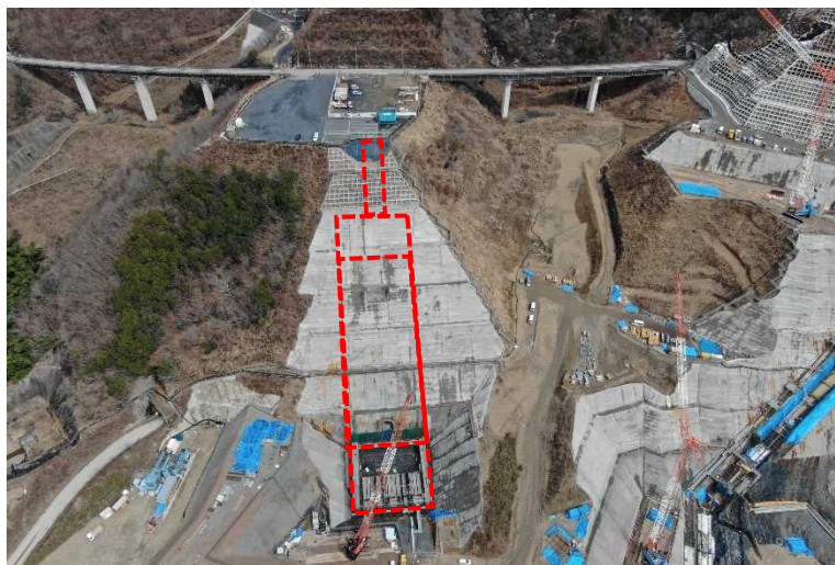
選択取水塔工 施工状況(令和4年3月)
