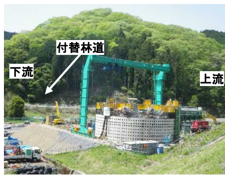
南摩注水工 施工状況(令和4年4月)
