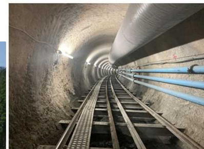
送水路坑内施工状況
