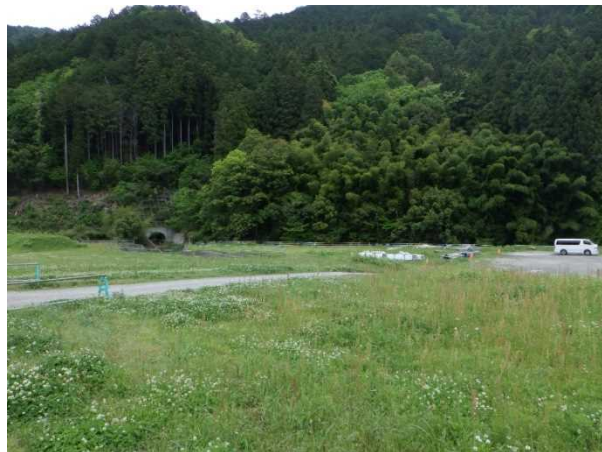
送水路 着工前
