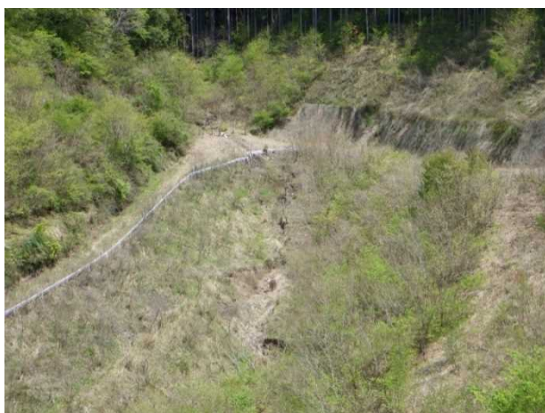
サージタンク工 着工前
