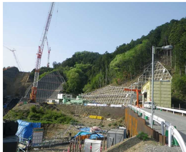
送水路施工ヤード整備工 施工状況 (令和4年4月)
