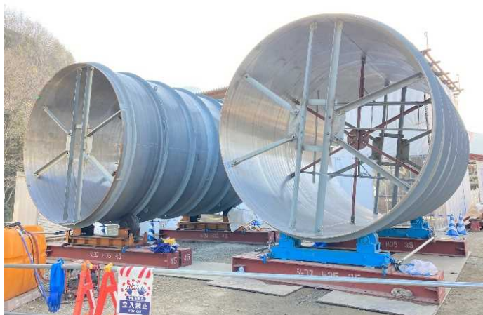
①利水放流管製作中(上流側仮工場) 施工状況(令和4年3月)
