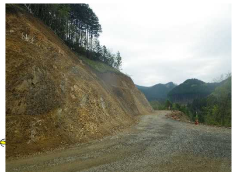
⑧付替林道左岸中流1工区工事 (R3.3.31~R5.5.29)
