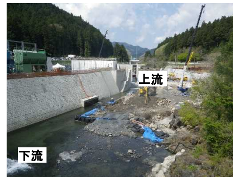
大芦川取水放流工 施工状況(令和4年4月)
