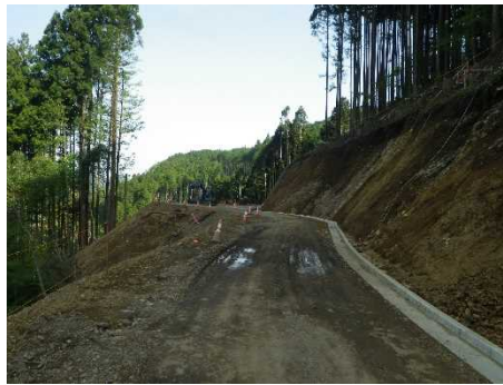
⑥付替林道梶又6工区他工事 (R3.3.24~R4.7.26)
