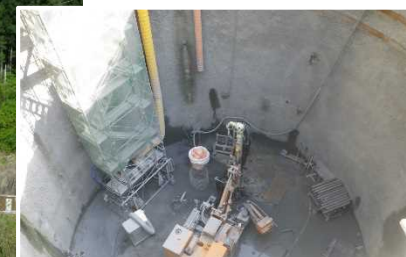
サージタンク内部施工状況
