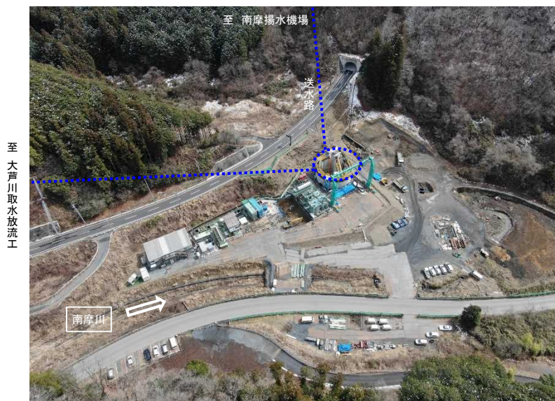
南摩注水工 施工状況(令和4年3月)
