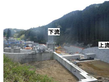
黒川取水放流工 施工状況(令和4年4月)
