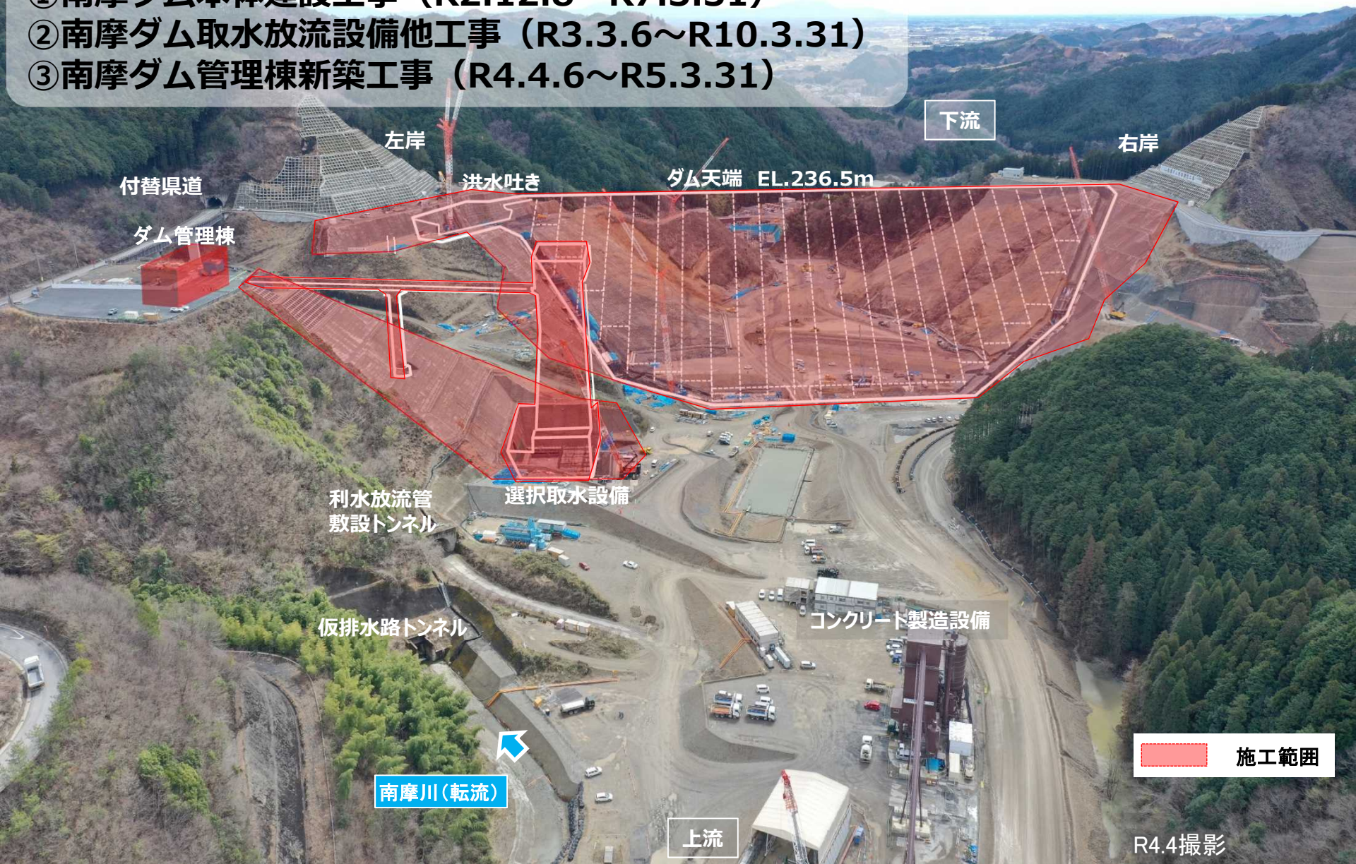
ダム本体等施工状況((堤体上流側から下流方向を撮影)
