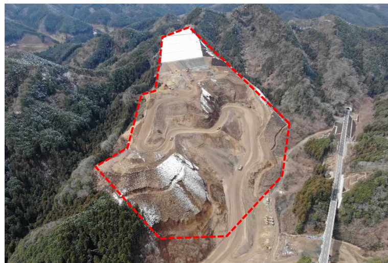
原石山掘削 施工状況(令和4年3月)
