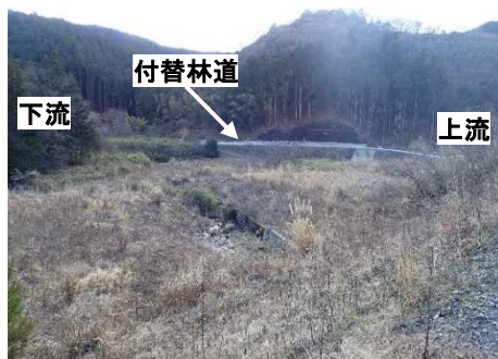
南摩注水工 着工前
