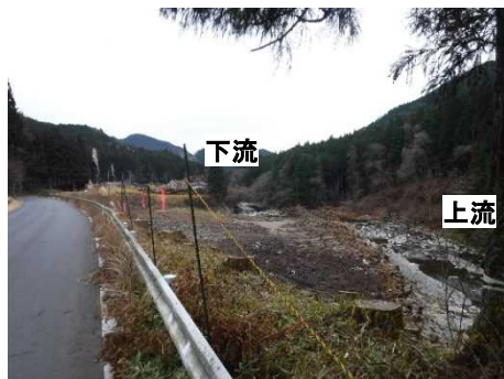
黒川取水放流工 着工前
