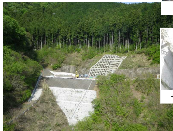
サージタンク工 施工状況 (令和4年4月)
