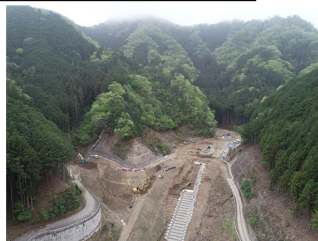
②付替林道奈良出1工区工事
