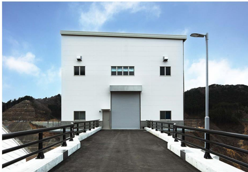
選択取水設備建屋（令和7年4月撮影）
