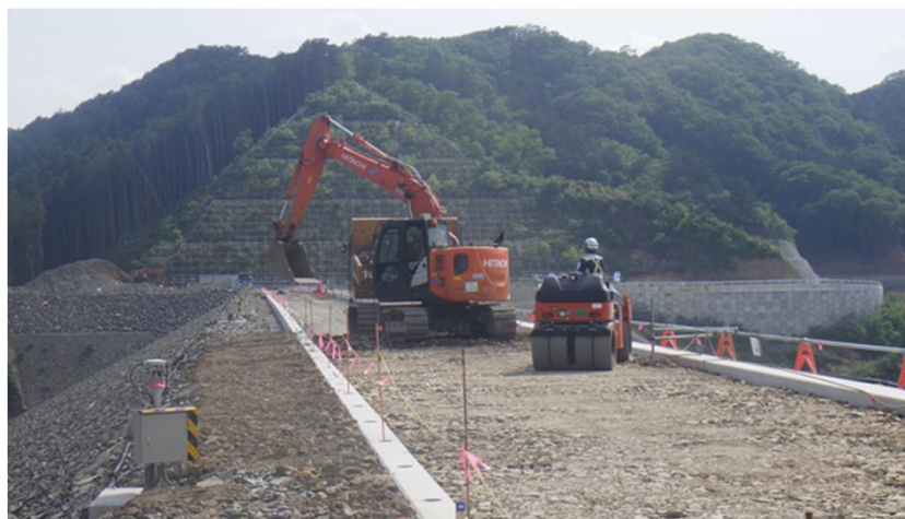
堤頂整備工 施工状況 (令和7年5月)
