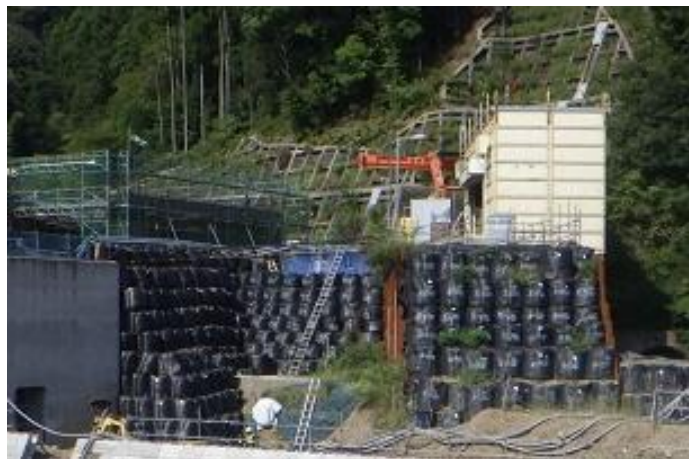
送水路施工ヤード整備工 施工状況（令和7年3月）
