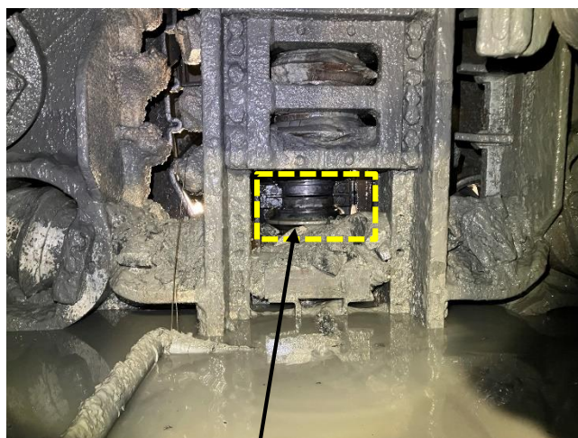
大芦工区側から確認した 南摩工区のシールドマシン
