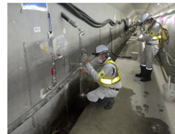
貯水池巡視状況(堤体内)
