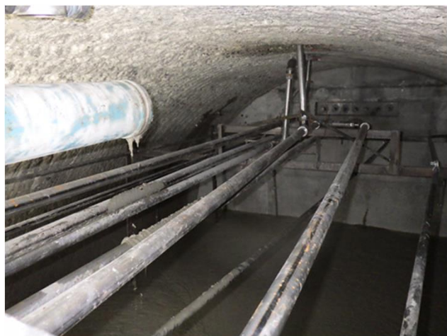
閉塞工 施工状況 (令和7年5月)
