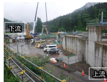
黒川取水放流工 施工状況（令和7年5月）
