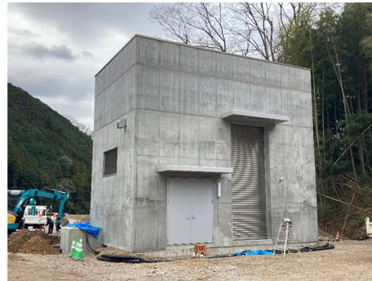
浸透量観測室（令和7年4月撮影）
