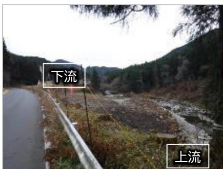
黒川取水放流工 着工前
