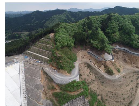
①付替林道神谷1工区工事
