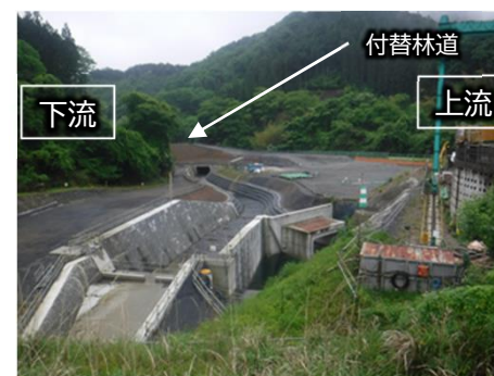
南摩注水工 施工状況（令和7年5月）
