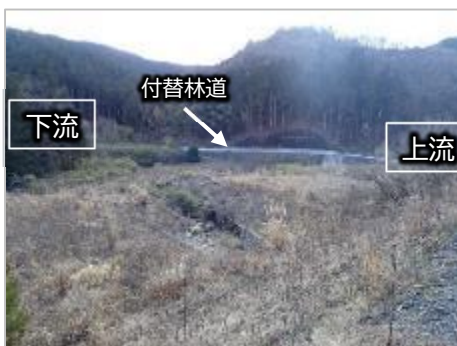
南摩注水工 着工前
