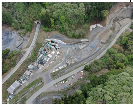
④付替林道左岸上流1工区工事
