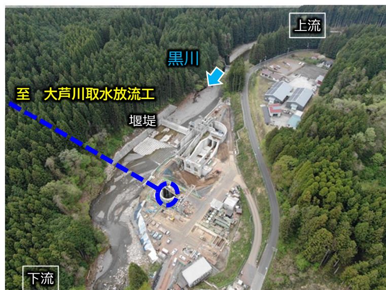
黒川取水放流工 施工状況（令和7年4月）
