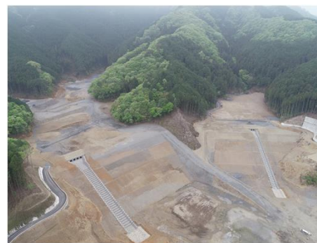
⑤付替林道沢ノ入7工区他工事
