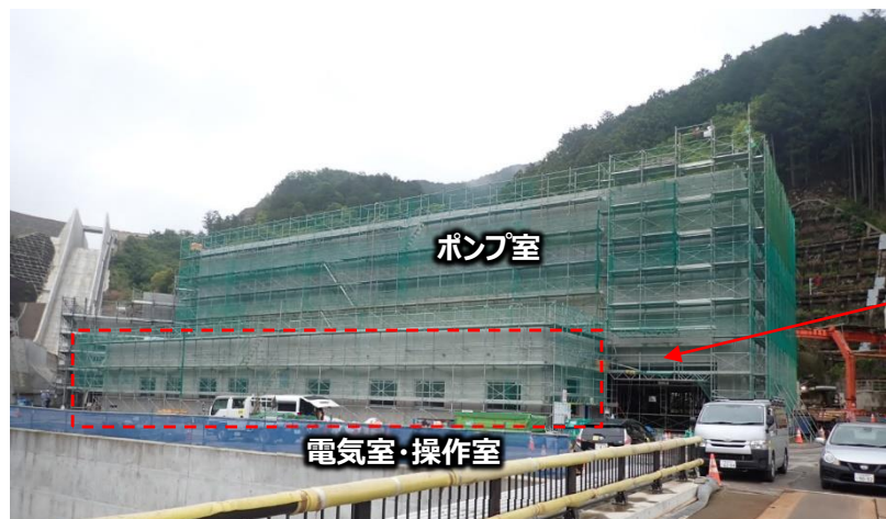
建屋 施工状況（令和7年5月）
