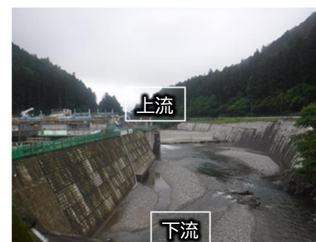
大芦川取水放流工 施工状況（令和7年5月）
