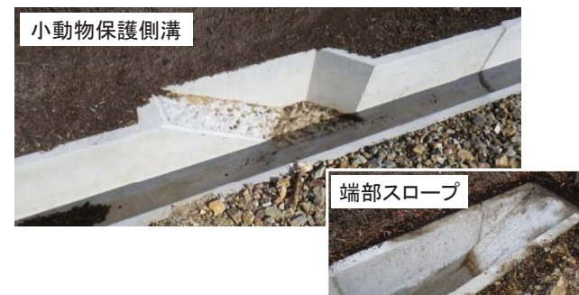
付替県道粟沢工区での対策事例
