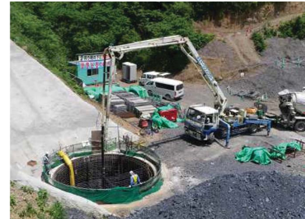
付替県道8号橋下部工での深礎工事状況
