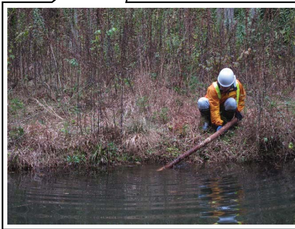
搬入作業状況
