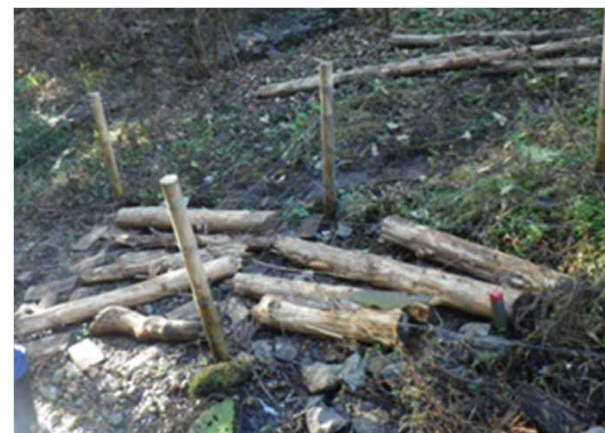
保全整備地6の状況(H30.12) 伐採木の敷設状況
