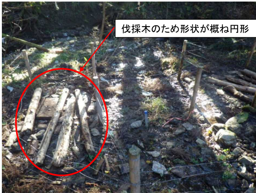
保全整備地7の様態(H30.12) 伐採木の敷設状況
