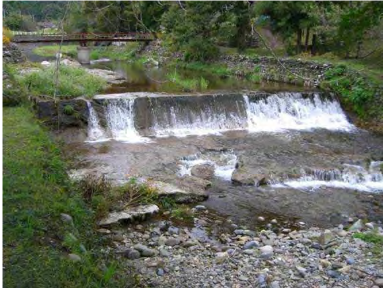
室瀬堰（南摩川約 7.9km 地点）
