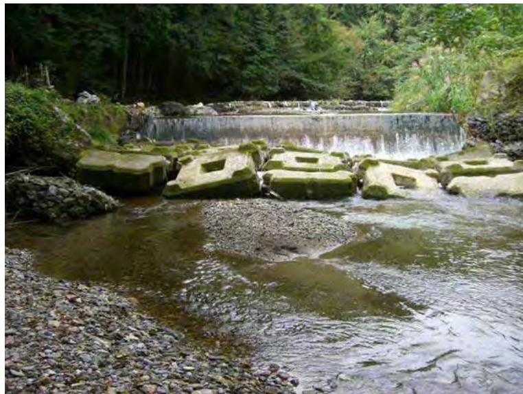
三石堰（南摩川約 8.3km 地点）
