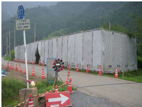
防音シートの設置状況
