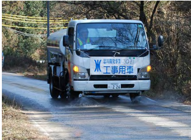
散水作業の状況
