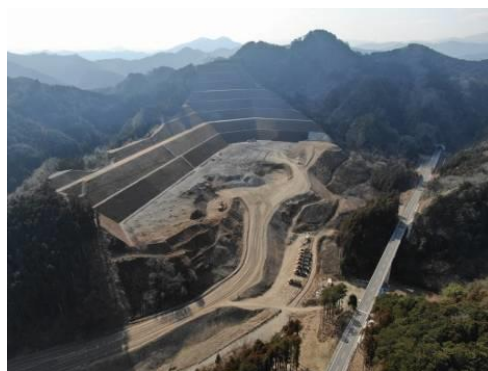
原石山工事状況(R5.3月)
