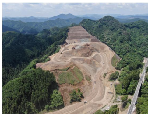
6段目まで掘削完了(R4.5)
