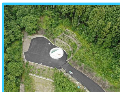
サージタンク立坑
