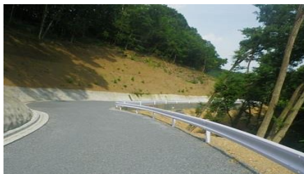
左岸下流1工区 R5.7竣工
