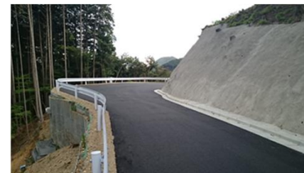
奈良出3工区 R5.8竣工
