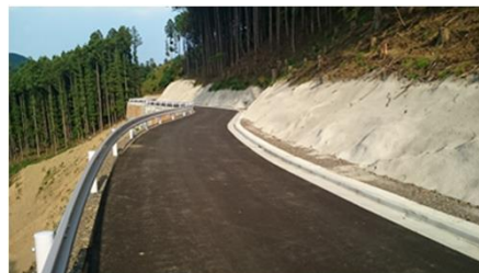
梶又2工区 R5.7竣工
