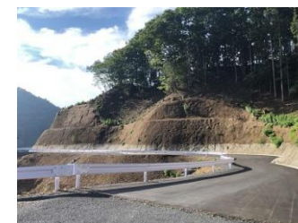
沢ノ入16工区 R6.8竣工
