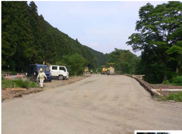
南摩ダム場内工事用道路工事
