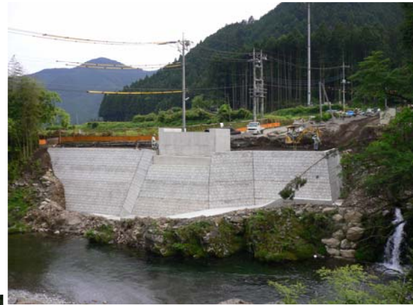
大芦川工事用橋梁下部工工事
