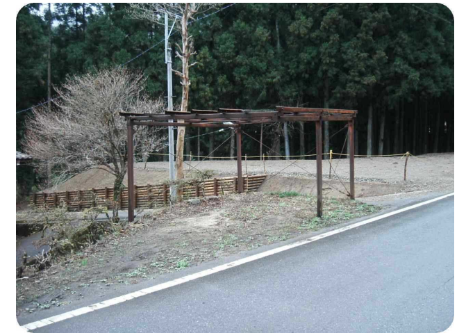
資材置場完成状況
