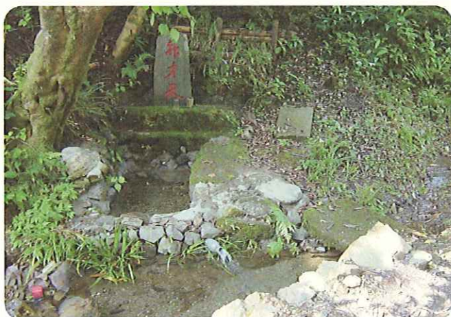
↑ 修復後の弁財天（南摩川水源） 足場も整備され、水が汲みやすくなりました。
