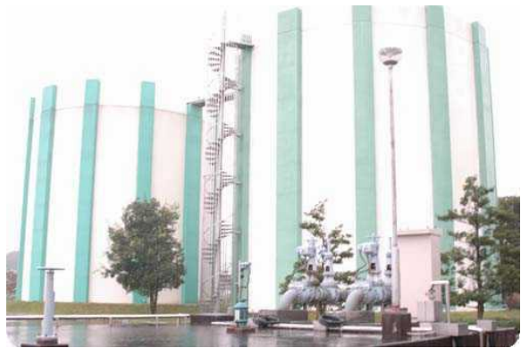
浄水を貯める配水池（川妻浄水場）
