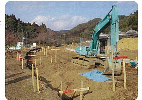
↑ 1/18現在の工事の様子
