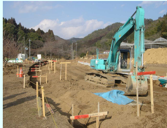
施工中の付替県道
