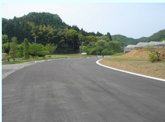
完成後の付替県道
