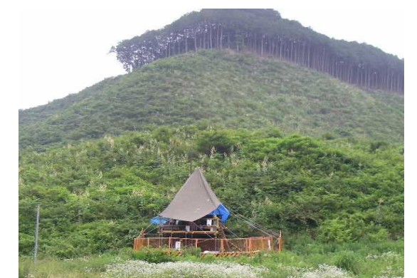
ダム地点のボーリング調査
