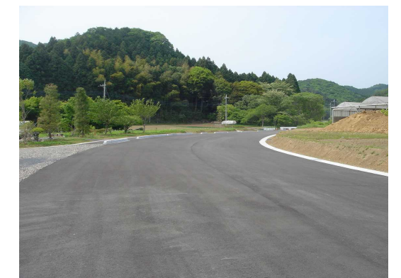
完成した付替県道の一部
