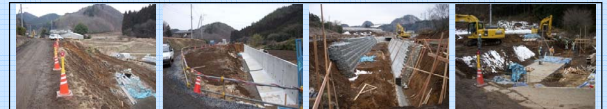
杓子沢2工区その1工事
