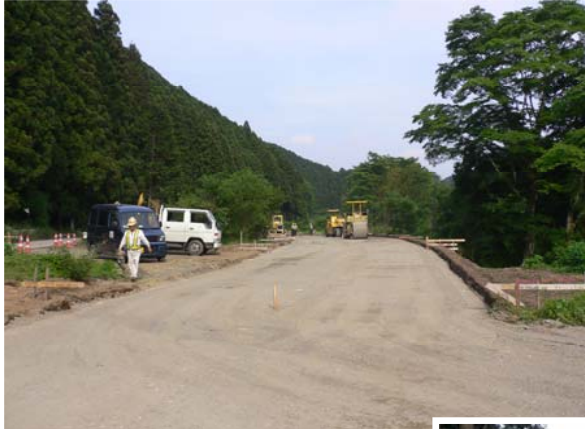
南摩ダム場内工事用道路工事
