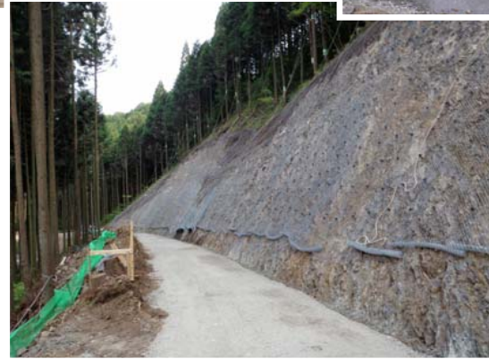
付替県道4号トンネル工事用道路工事
