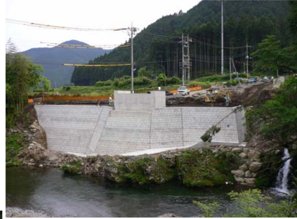
大芦川工事用橋梁下部工工事
