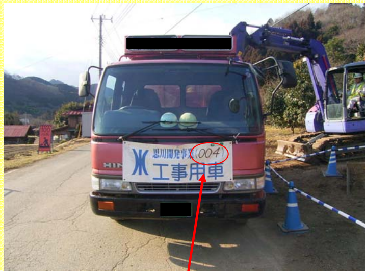
「番号」と「番号の色」で工事が判別できます。
