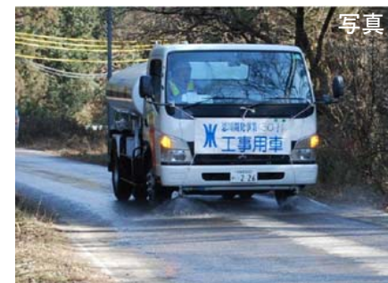
散水車による水まき
