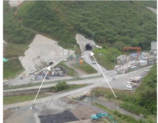
仮排水路トンネル及び放流管敷設トンネル
