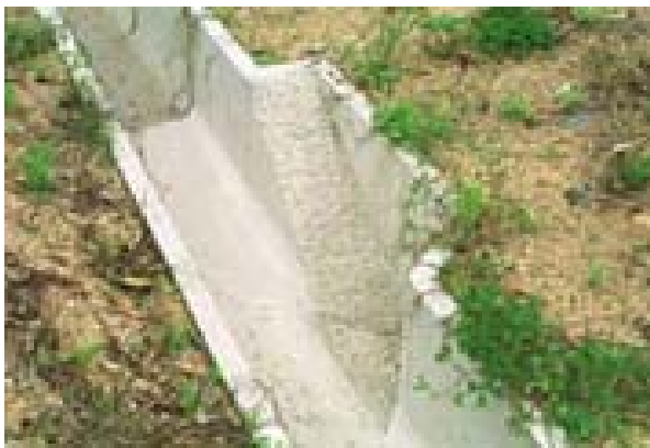
写真1 スロープの付いた側溝
