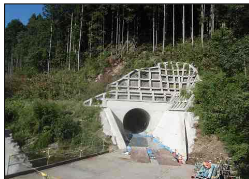
仮排水路トンネル(下流側吐口)
