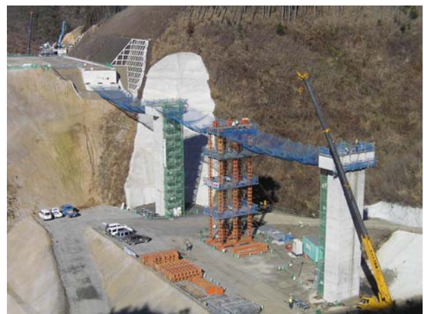
ダムサイト左岸から見た付替県道8号橋
