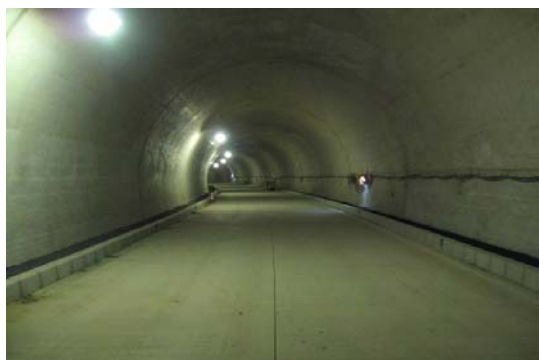
完成間近の付替県道4号トンネル
