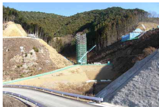
付替県道5号橋下部工工事
