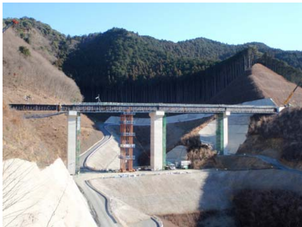
付替県道6号橋の全景
