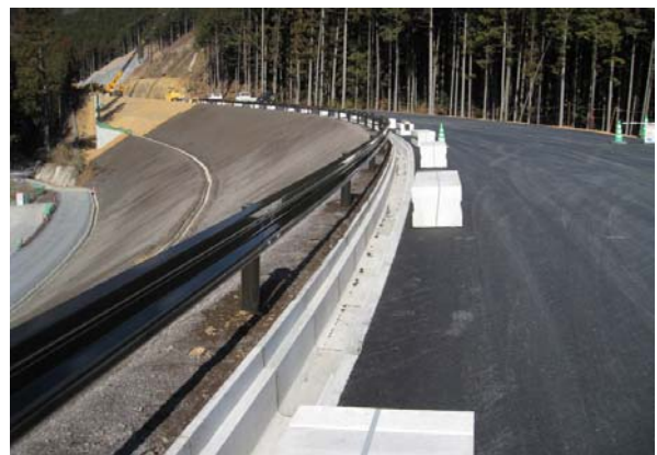
写真2 杓子沢工区に設置したガードレール
