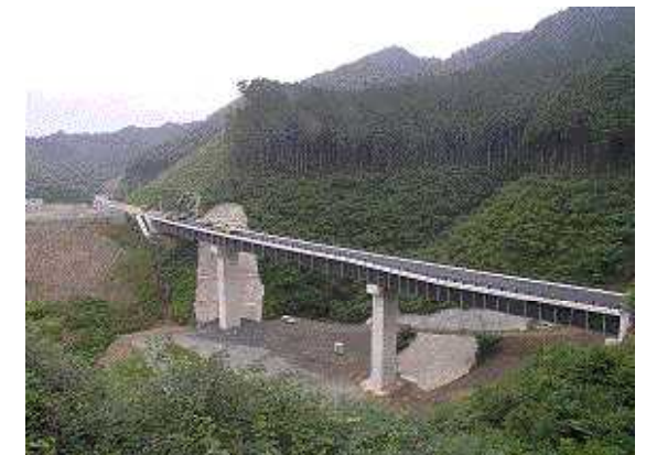
8号橋全景(ダムサイト左岸側より)
