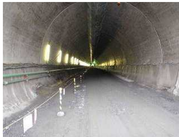
覆工施工後（8月4日現在、942mのうち503m完了）
