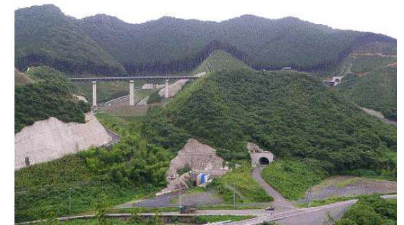
6号橋(左)・8号橋(右)全景(貯水池側より)
