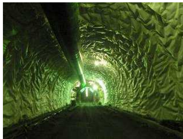
覆工施工前（防水シート施工後）
