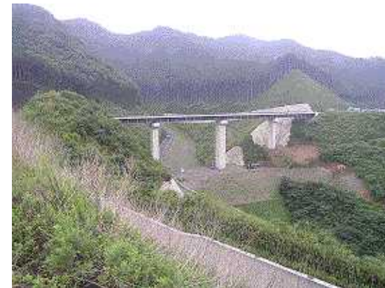
6号橋全景(上流側左岸より)
