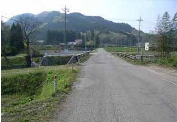
室瀬橋附近（改良前：昭和方面から室瀬方面をのぞむ）
