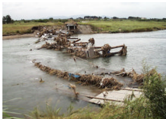
被災した間中橋（7月19日）
