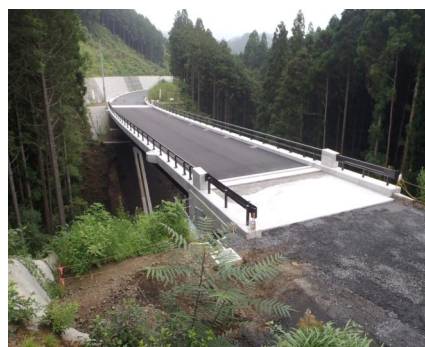
「完成した付替県道7号橋」
