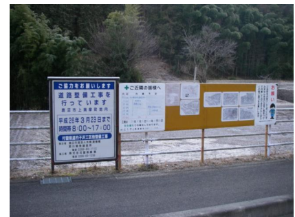
【工事内容をお知らせする掲示板】
