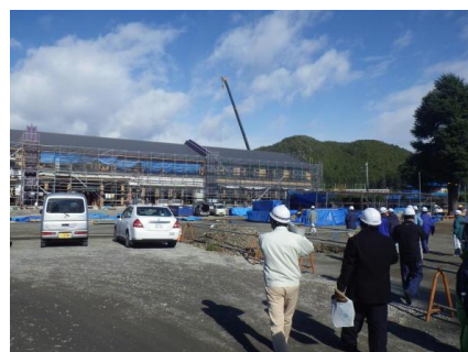
【工事が進む新木造校舎】
