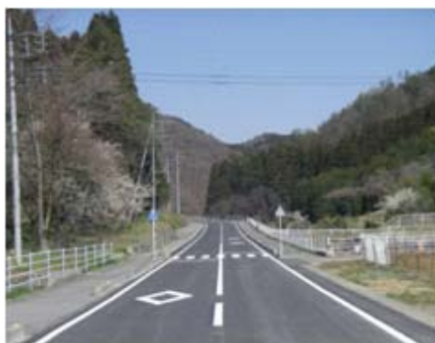
【杓子沢地区の道路舗装及びブロック擁壁築造の状況】
