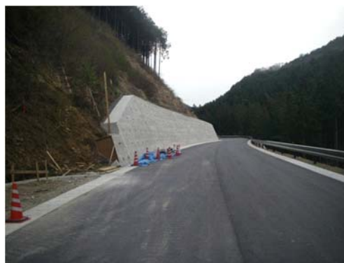
【杓子沢地区の道路舗装及びブロック擁壁築造の状況】
