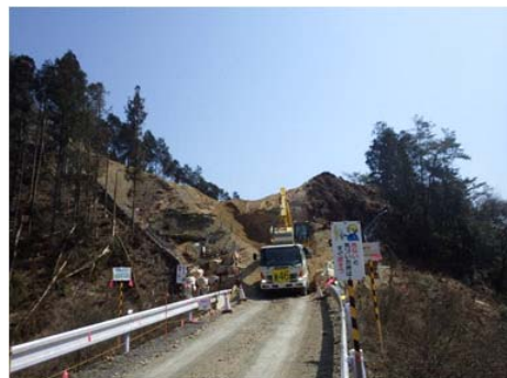
【粟沢地内 山の切土工事】
