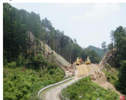
【粟沢7工区工事】
