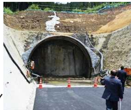
【引田側坑口付近】
