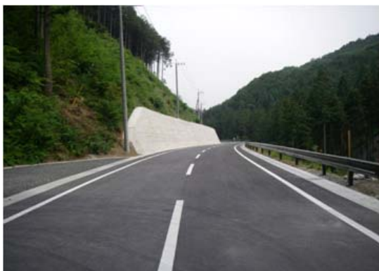
【完成した杓子沢工区】
