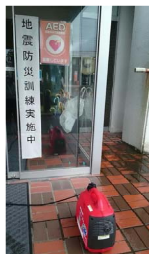
【訓練実施中の表示と発電機】
