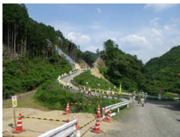
【付替県道粟沢7工区】
