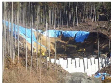
【谷間を埋め戻す土が崩れないよう支える壁を造っています】
