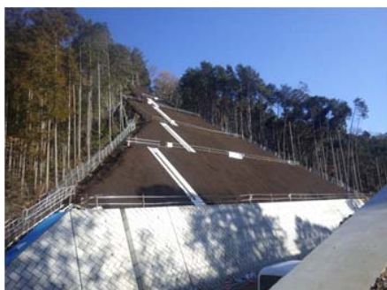
【斜面への森林表土吹付け状況と完成したコンクリートブロック壁】
