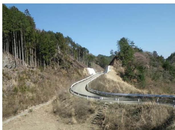
【完成状況（平成27年3月）】
