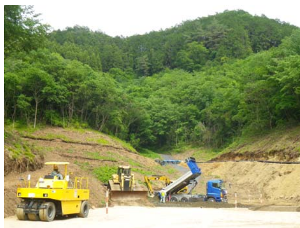
【工事実施状況（平成27年6月下旬）】
