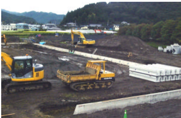
上南摩(上) 西沢(下)の各移転代替地
