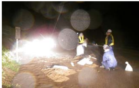
【鹿沼市広蔵寺付近での土のう作り】
