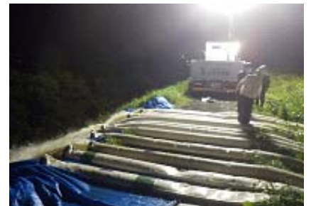
【小山市羽川西浄水場での排水作業】
