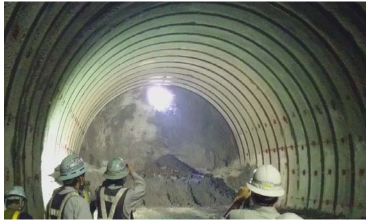
【貫通の光が射したトンネル内】
